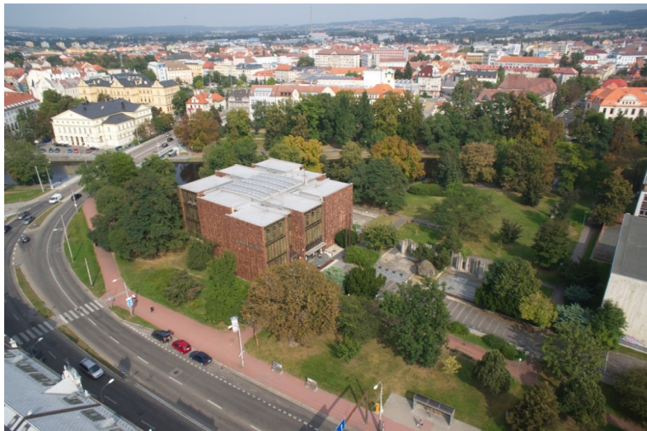
Jihočeská vědecká knihovna sídlí v objektu bývalého Muzea dělnického hnutí, postaveného v letech 1971-75 podle projektu Jana Maláta, Jiřího Víta, Jana Řezníčka a Miloše Sádka.
